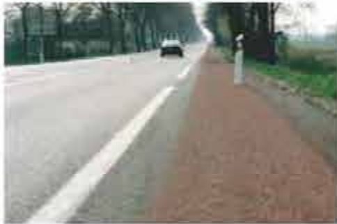
Exemple d'accotements stabilisés
